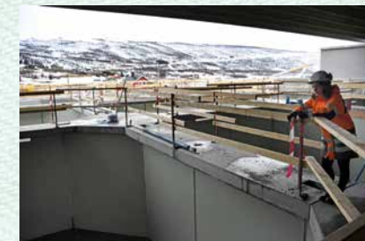
Settefiskanlegget begynner å ta form ute ved Dåfjorden.
