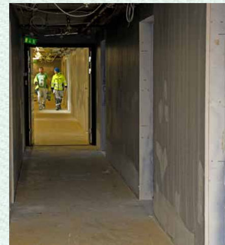
Consto har tatt for seg et par etasjer i slengen. Slik ser det ut før nye tak, vegger og gulv kommer på plass.
