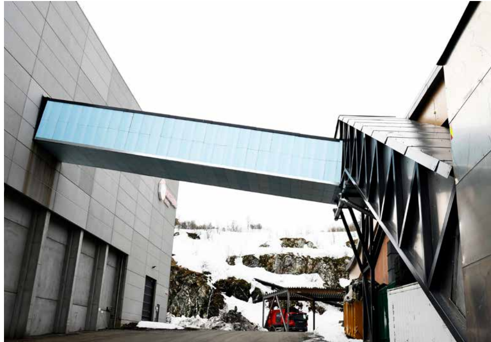
En tunnel med transportbånd sørger for direkte transport fra produksjonshallen og inn til Kvitebjørn Varme.
