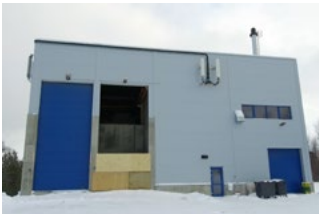
Slik ser fjernvarmeanlegget i Alta ut.
