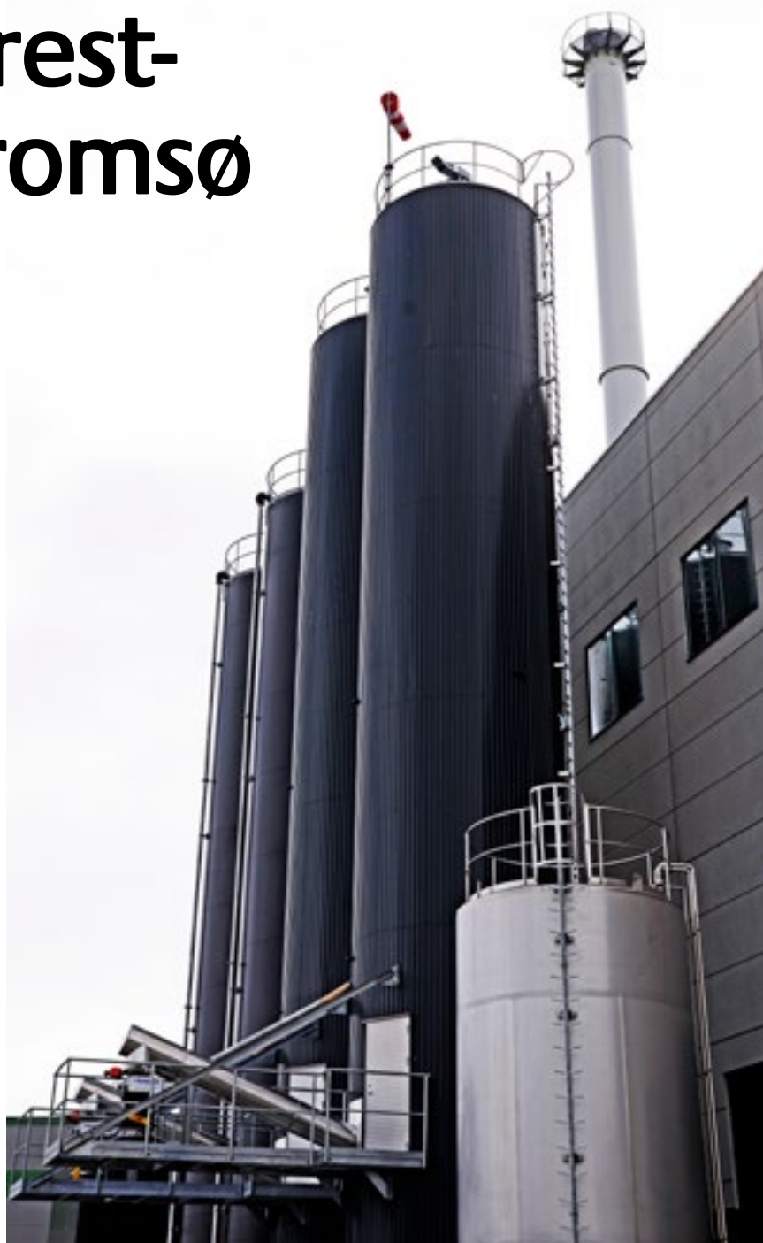
Anlegget til Kvitebjørn Varme.
