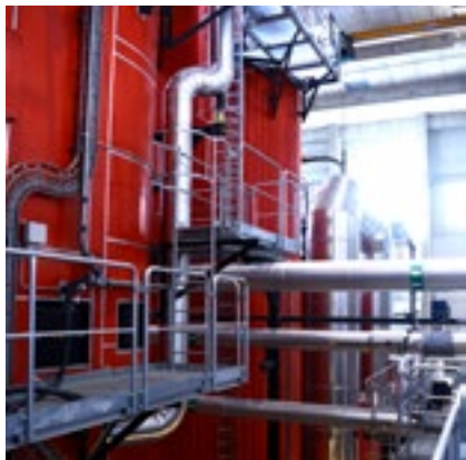
Bilde fra innsiden av anlegget.
