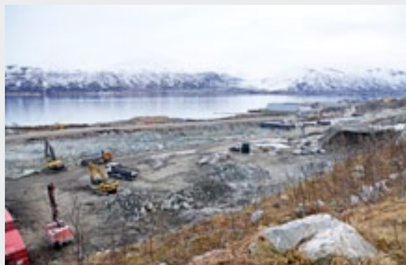
En sterk industriell trio blir å vokse fram i dette området nord på Tromsøya: Remiks Miljøpark, Kvitebjørn Varme og Tromsø Skipsverft.
